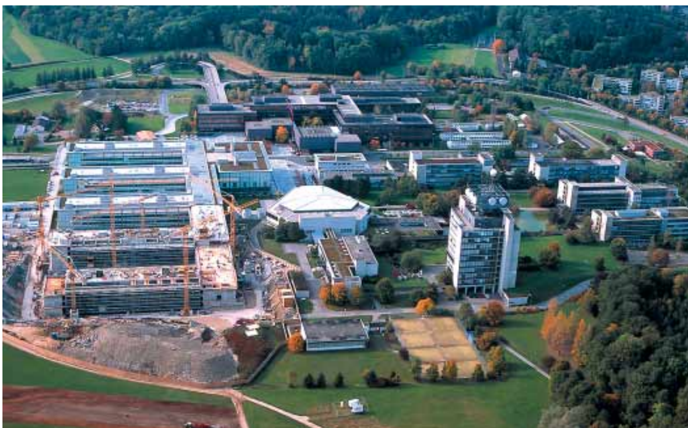
Baustelle Hönggerberg: «Chemie und Angewandte Biowissenschaften» werden im Herbst 2004 auch räumlich vereint.
