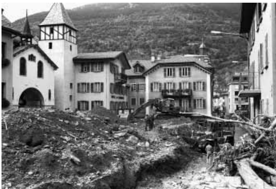
Abb. 1: Geröllablagerung in Brig durch die Saltina nach dem Unwetter vom 22.–24. September 1993. (Bild: Renato Jordan)
