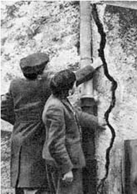
Schulkinder bestaunen nach dem Erdbeben von Villeneuve (1946) einen Riss in der Hausmauer.
